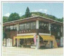
道の駅「青雲橋」
